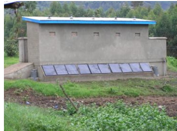
Achterzijde ecosan toilet
